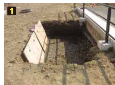
路床部分に生育用基板樹を掘る。
