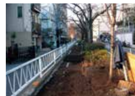
2. 歩道部分にパワーミックスを施工。
