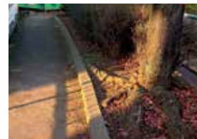
1. 施工前の様子。
