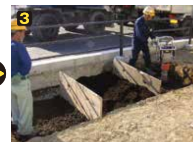
根系伸長域にパワーミックスを一層20cm厚みで投入し、振動プレートにて転圧を加える。
