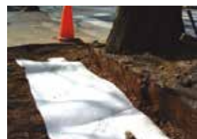
3. 縁石にルーツストップ(防根シート)を施工。
